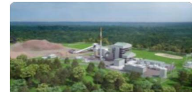
Biomass - S. Boston 50 MW - USA
